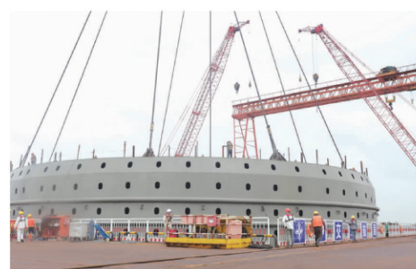
深中通道伶仃洋大桥东索塔上游侧巨型钢吊箱下放施工过程
