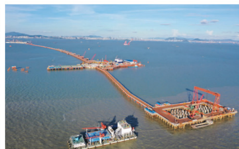
深中通道伶仃洋大桥施工现场全景
