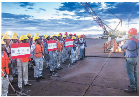
钢吊箱下放前的施工组织动员
