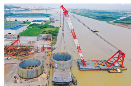
深中通道伶仃洋大桥东索塔钢吊箱装船过程
